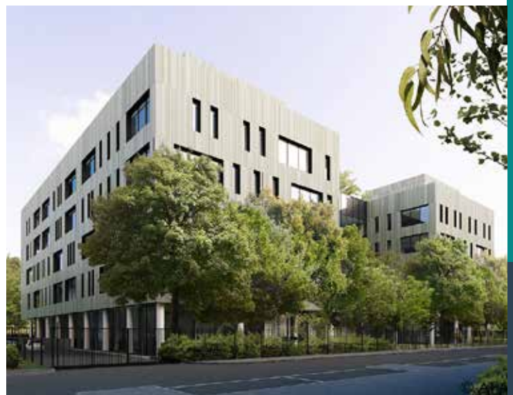
Vue du siège d'Artelia depuis la nouvelle voirie Est-Ouest
