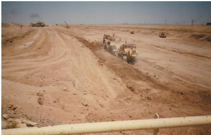
En section courante, pour les revêtements en terre, en cas de défaillance, les réparations ont pu se faire plus facilement cependant que sur les sections revêtues par une membrane.
